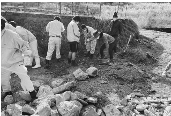
(図7) 基本の床掘り作業を学ぶ様子
