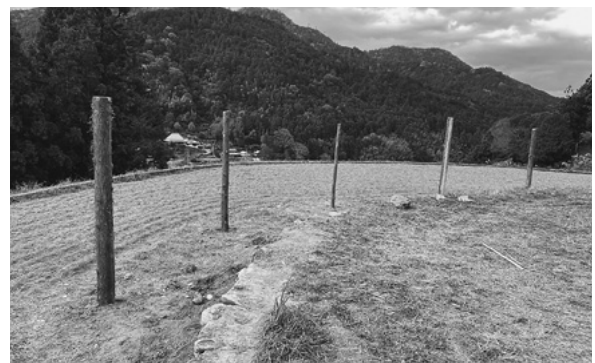
土どめで間伐材スギを支柱に埋め込んだ様子
