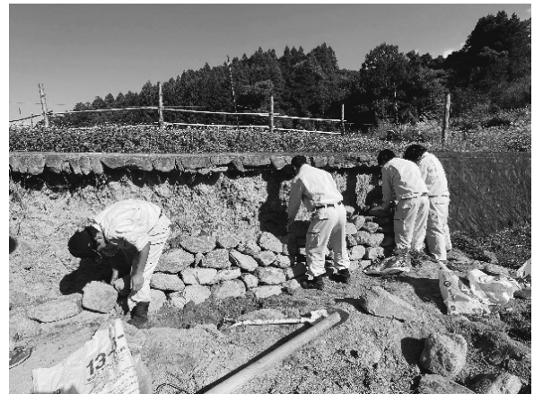
図⑥着実の石を積み完成させる様子
